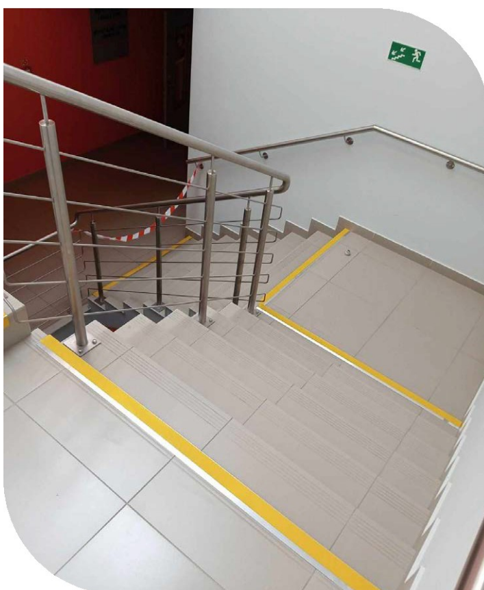
Dostawa i montaż aluminiowych kątowych nakładek wraz polami uwagi na stopnie istniejących schodów w budynku Uniwersytetu Pedagogicznego przy ul. Podchorążych 2 w Krakowie
